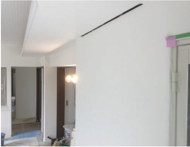
①LD壁面・下り天井、クロス施工
