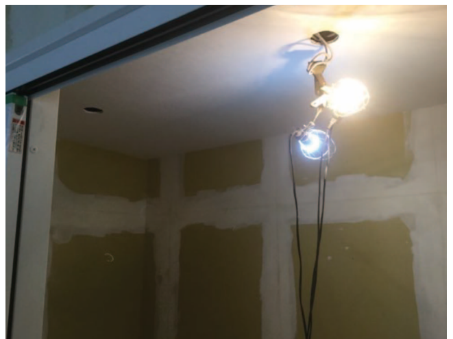
⑥廊下・ホールの天井、クロス施工
