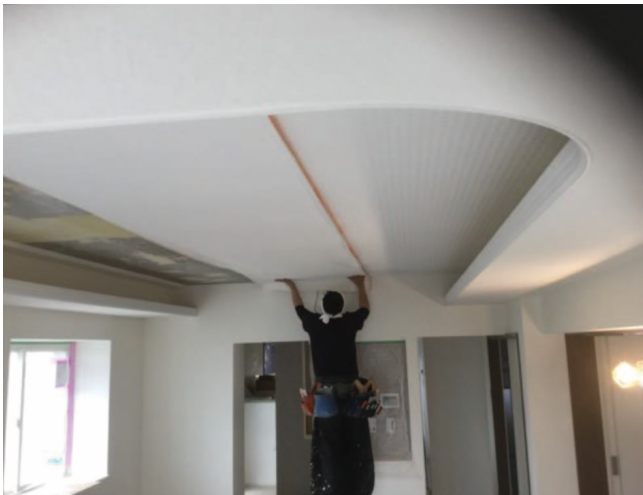
③LD、高天井のクロス施工
