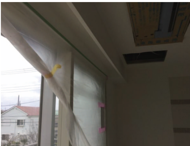
⑤LDカーテンボックスクロス施工
