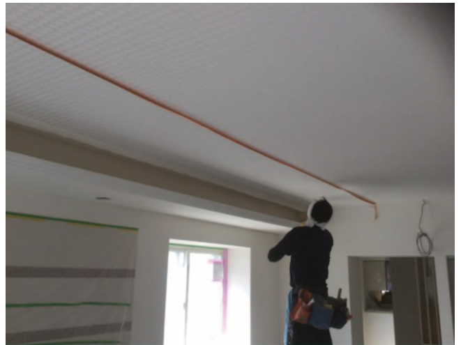
④LD、高天井のクロス施工、仕上げ
