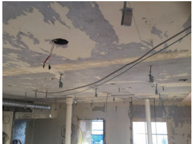
④キッチン・洗面、天吊ハンガー組み
