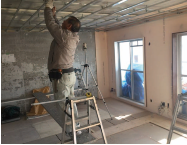
①寝室側、レーザーで天井の高さ調節
