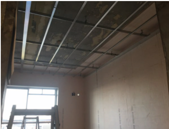
③高さ調整前の客間の天井下地組み
