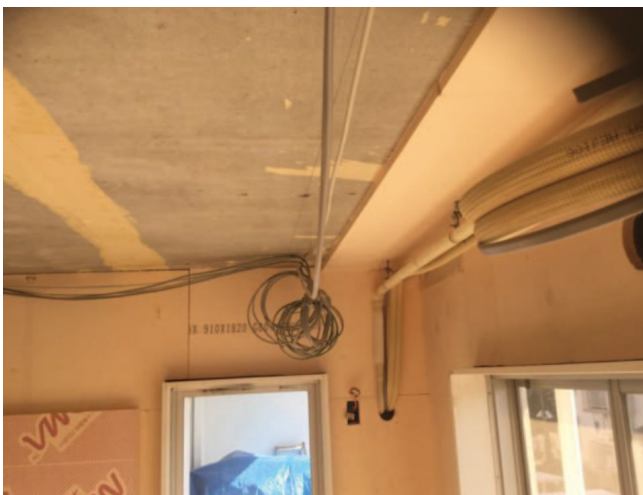
⑤LDの下り天井部の先行配線
