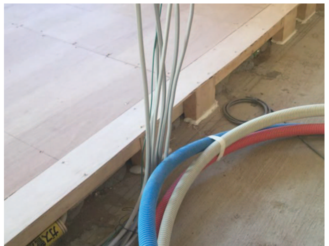
⑥キッチン、浴室へ床延長の根太組み
