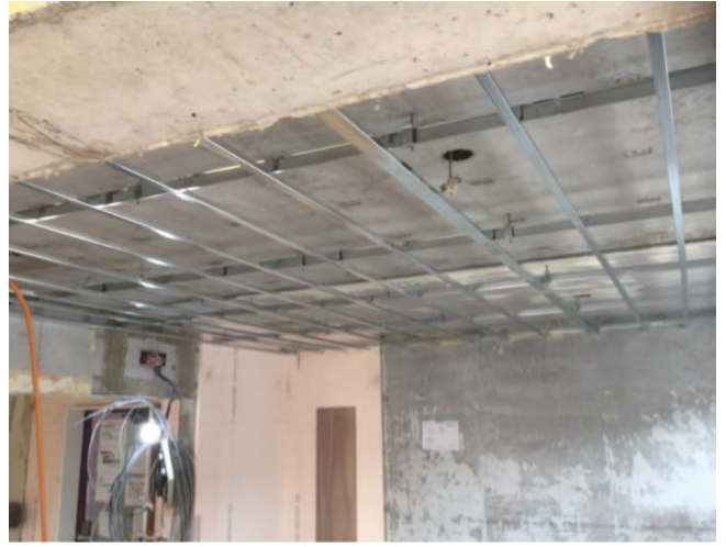
②寝室側・書斎・WICの天井組み完成
